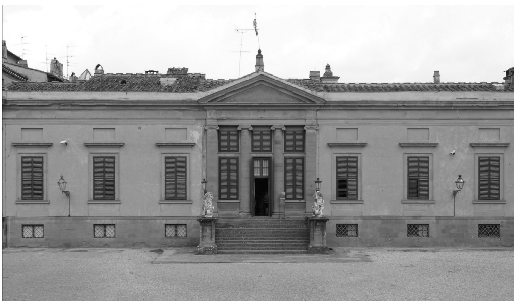
Fig. 2. The Palazzina della Meridiana.
